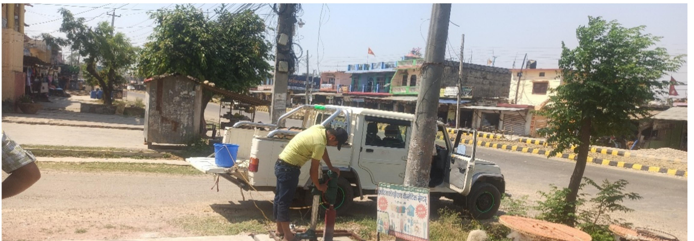
१९ सैया को अस्पताल निर्माण कार्य
